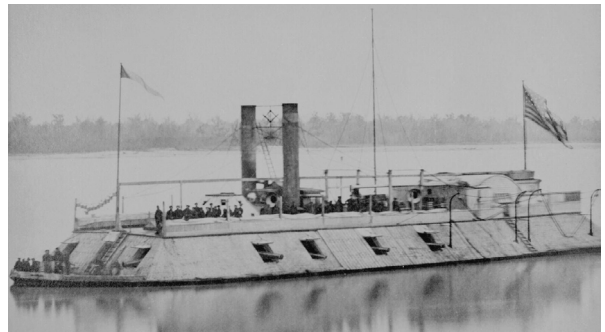
เรือ Ironclad มีตัวเรือแบบ Tumblehome และกราบเรือต่ำ เหมาะกับการใช้งานในแม่น้ำแต่ไม่เหมาะกับสภาพคลื่นลมในทะเลในช่วงสงคราม Civil War ภาพถ่าย ในเดือนตุลาคม ค.ศ.๑๘๖๒
