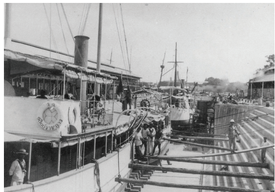
อุคอนกรีต สำหรับการสร้าง - ซ่อมเรือแห่งแรกของประเทศไทย สร้างแล้วเสร็จในปี พ.ศ.๒๔๕๙ ในภาพเป็นการเตรียมการซ่อมทำเรือในอุแห่ง ซึ่งมีประตูกั้นพื้นที่ชั้นนอกและชั้นใน ทำให้กรมอุทการเรือสามารถบริหารงานซ่อม - สร้าง เรือรบของกองทัพเรือตอบสนองภารกิจได้หลากหลาย
